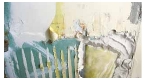
Nach Fliesendemontage lassen sich statt 0,2 nur 0,21 mm Trockenschichtstärke (gelb) messen.
