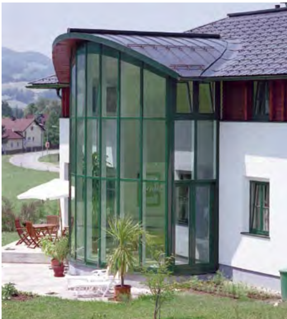
Leicht: Metallschindeln haben wenig Gewicht und sind besonders sturmsicher
