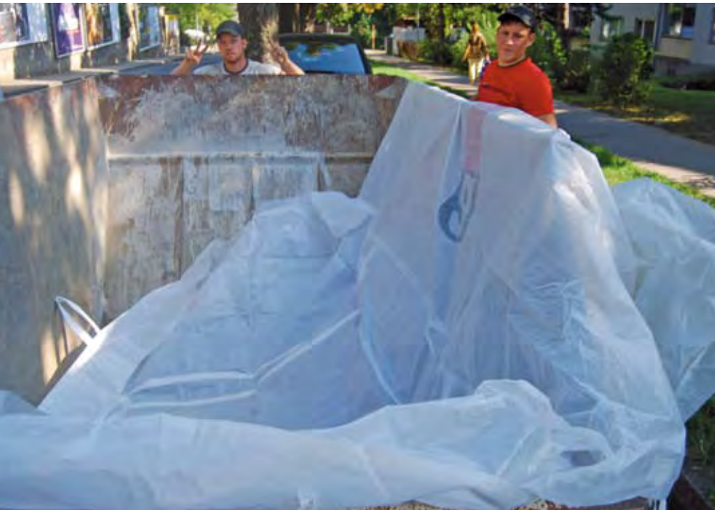
Eingepackt: Der Container muss mit einer winddichten Folie ausgelegt werden, bevor das Material darin landet.
