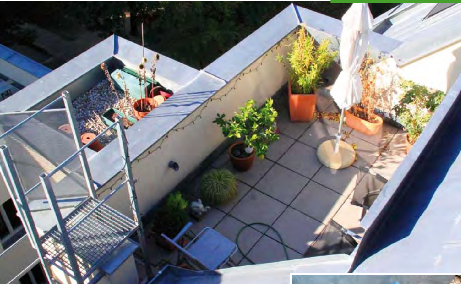
Kleine Terrasse mit Winkelblechen und Schutzanstrich möglich, besser die Abdichtung wannenförmig hochziehen.
