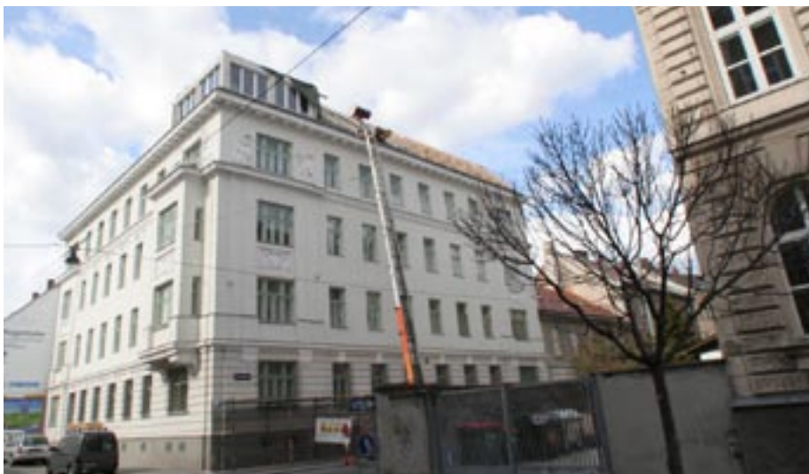
Architektonisch fügt sich der Dachausbau stimmig in das Fassadenbild ein
