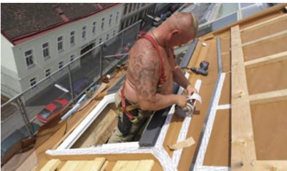
Der Unterdachanschluss im Fensterbereich will sorgfältig ausgeführt sein
