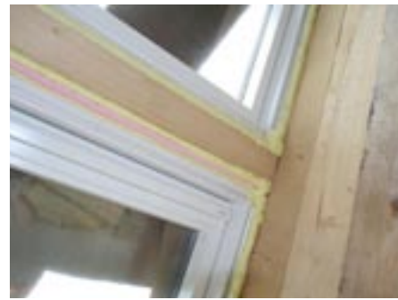
Für Passivhausdachfenster ist eine fugenlose Dämmung Voraussetzung
