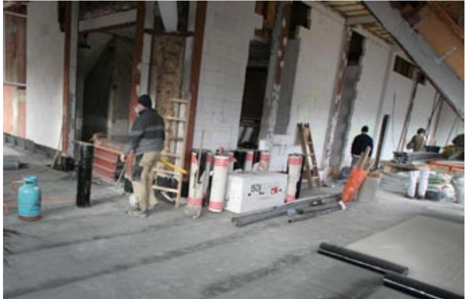
Kontrolle: Bei einem derart anspruchsvollen Projekt ist jede Detailschulung extrem wichtig
