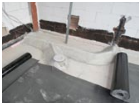
Baudetail: Die provisorische Bodenabdichtung wird über die Abwasserrohre verflämmt
