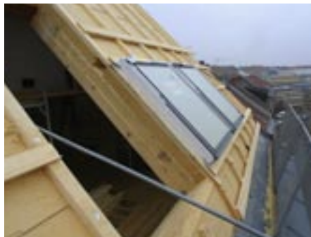
Aus 2 mach 1: der neue Dachstuhl mit wasserdichtem Unterdach in der Bauphase
