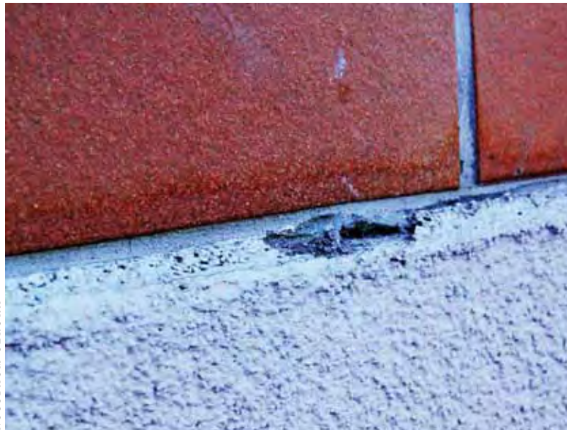
Der Oberputz bricht beim Fliesenanschluss aus.
