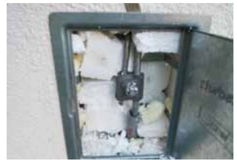
Das Blitzschutztürchen ist von der Fassade zum Rahmen und vom Rahmen zur Türe undicht.
