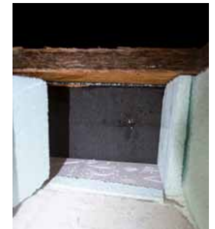
Hydrophobierte EPS-Platten im Bereich der Attikadämmung sind ohne Einschränkung verwendbar. Hauptsache, sie stehen nicht im Wasser.
